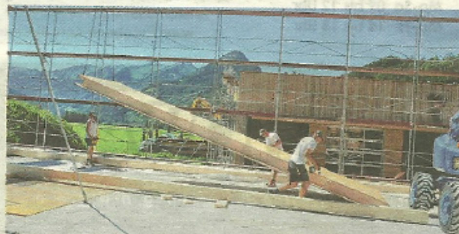
Der Bau in Schnepfau macht inzwischen große Fortschritte.
