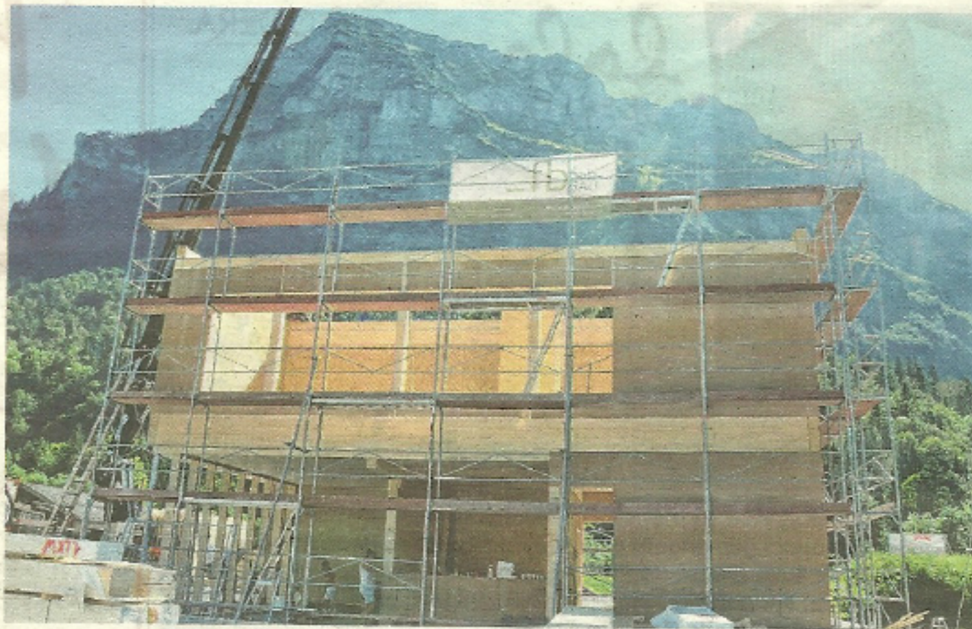
Nach einem Jahr Planungsphase sind inzwischen die Beton- und Maurerarbeiten des massiv gebauten Kellers fertiggestellt und das 25 x 14 m große Gebäude wächst in die Höhe. FOTOS: MAM
